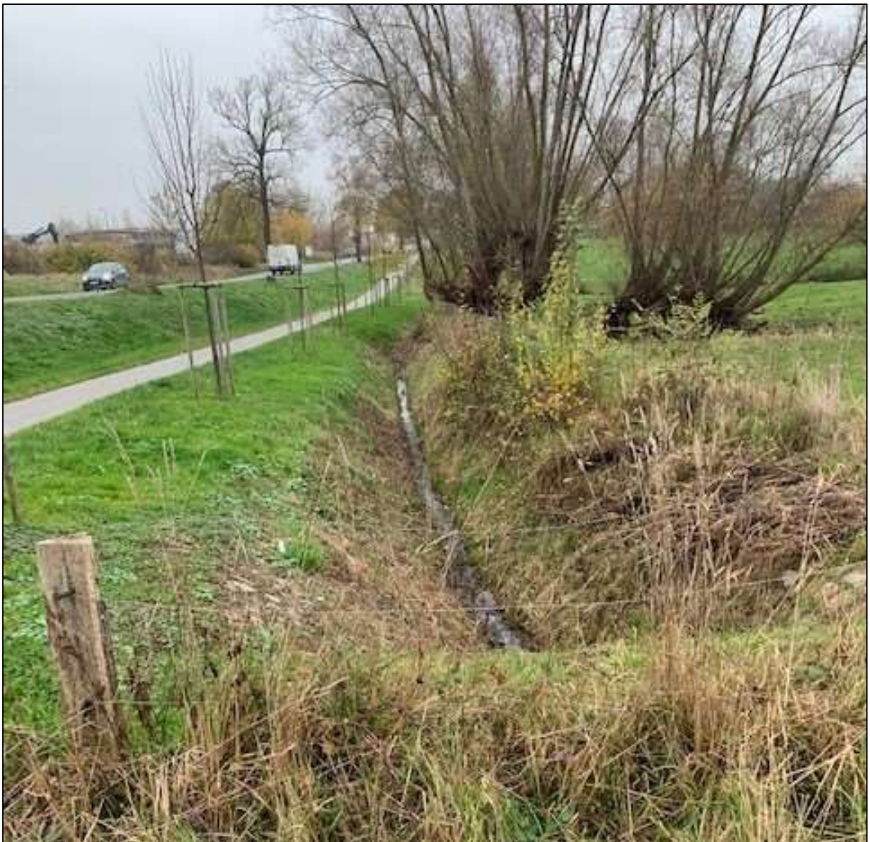
Abbildung 4: Gewässer II. Ordnung (Blickrichtung Osten); Baukonzept Neubrandenburg GmbH, November 2021
